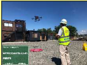
測量用のドローン導入
